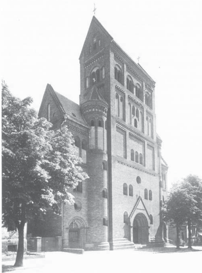
Rosenkranz-Basilika, erbaut: 1900, Architekt: Christoph Hehl
